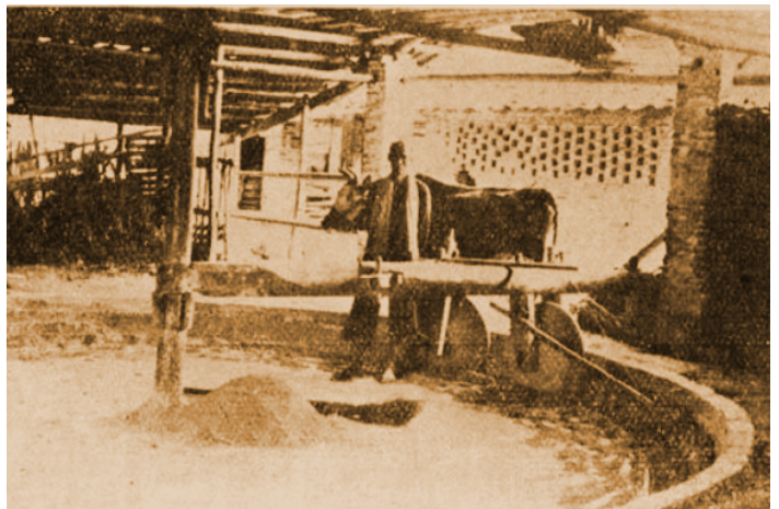
用一头牛拖动研磨机来研磨高岭土 (1939年, Vietnam, 印度支那半岛经济期刊)
